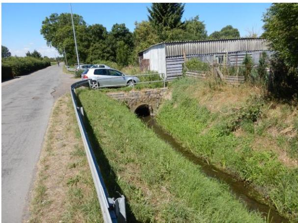
Abbildung 3-6: Rohrdurchlass Graben 25/1
