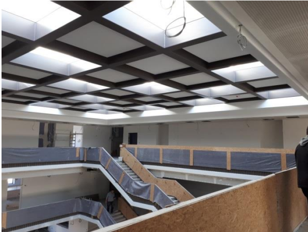
Abbildung 4: Bauzustand IGS Fischer, OG Atrium
