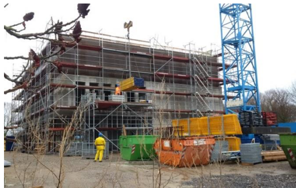
Abbildung 1: Rohbauarbeiten für das neue Stadtarchiv
