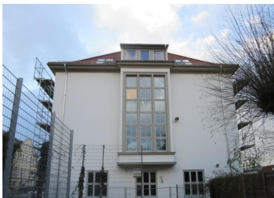
Abbildung 3: sanierte Nordfassade der Arndtschule
