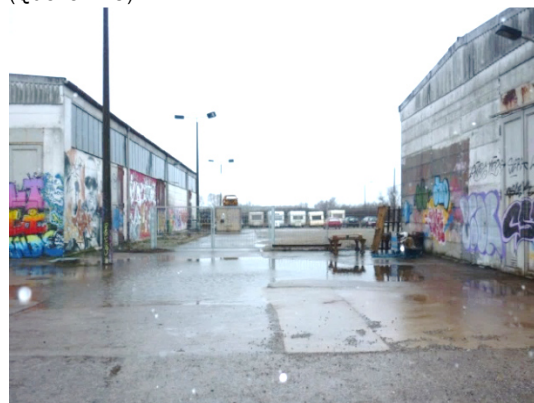
Abb. 10: Ungenutzte Hallen/Brachflächen (Quelle: IPO)
