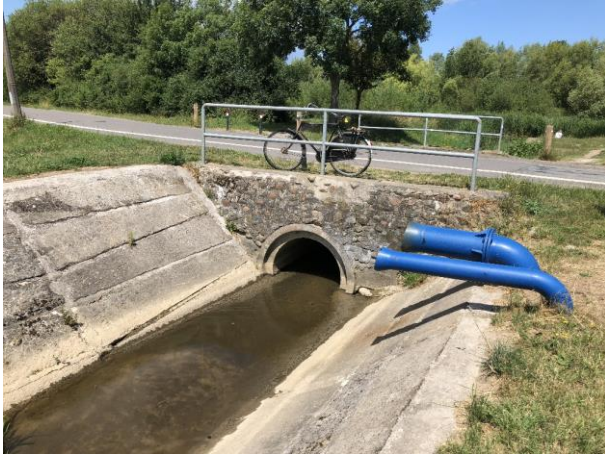
Abbildung 3-2: Auslauf Schöpfwerk Scharnhorststraße
