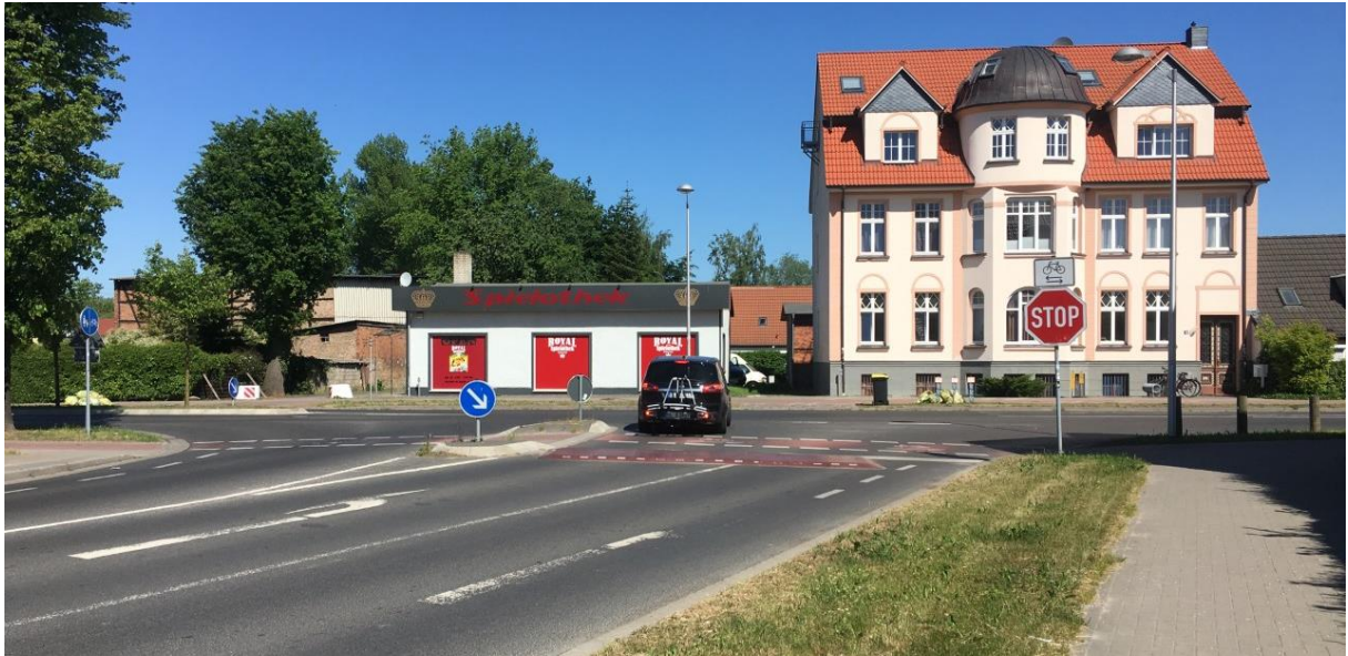
Abbildung 2 KP3 Zufahrt Loitzer Straße
