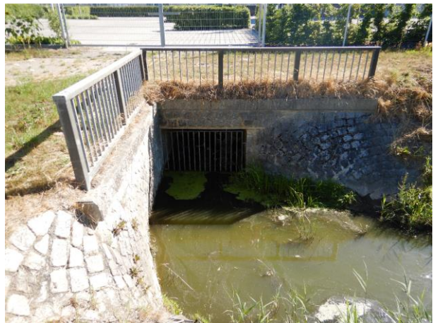
Abbildung 3-5: Kastendurchlass am Bahnhof
