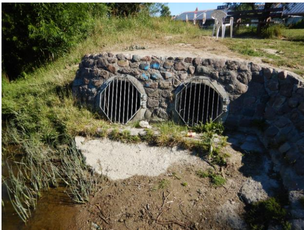
Abbildung 3-4: Zwei Auslässe des RRB
