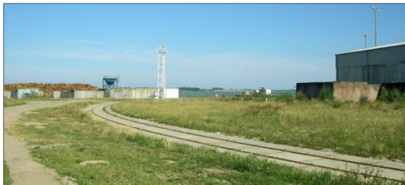
unternutzte Flächen des Hafens Ladebow
