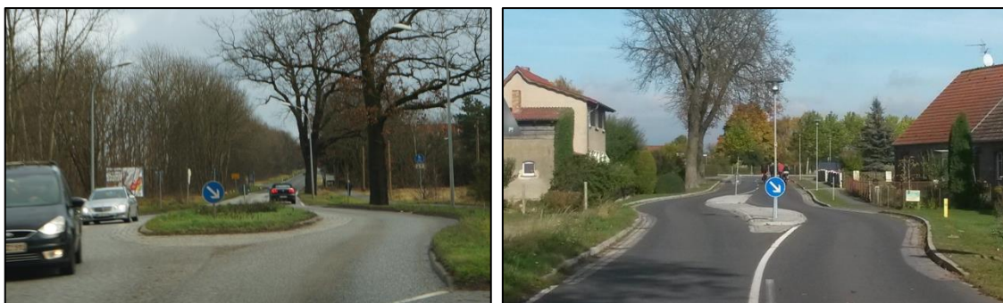
Abb. 24 Beispiele Ortseingangsgestaltung mit Fahrstreifenversatz
