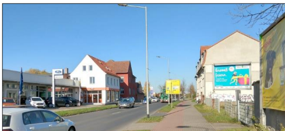
der von der Gebäudeflucht zurückgesetzte Flachbau mit Autohaus und Kfz-Werkstatt beeinträchtigt den städtebaulichen Zusammenhang
