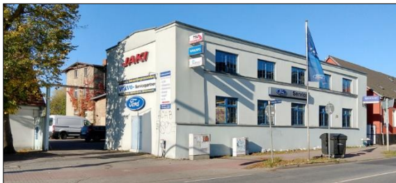
Kfz-Werkstatt in saniertem, stadtbildprägendem Gewerbegebäude in der Stralsunder Straße
