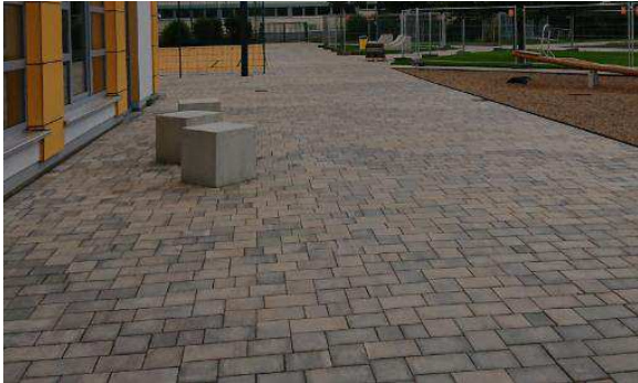
Hauptweg: Betonsteinpflaster, 5 Formate, wilder Verband, Farbe muschelkalkmix (wie Hof Fischer-Schule)
