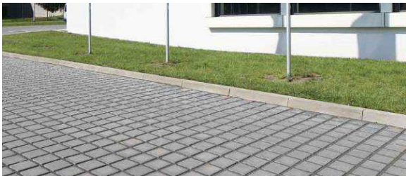
PKW-Stellflächen: Betonsteinpflaster, 20 x 20 cm, Dränfuge, grau, Behinderten-Stellplatz ohne Dränfuge
