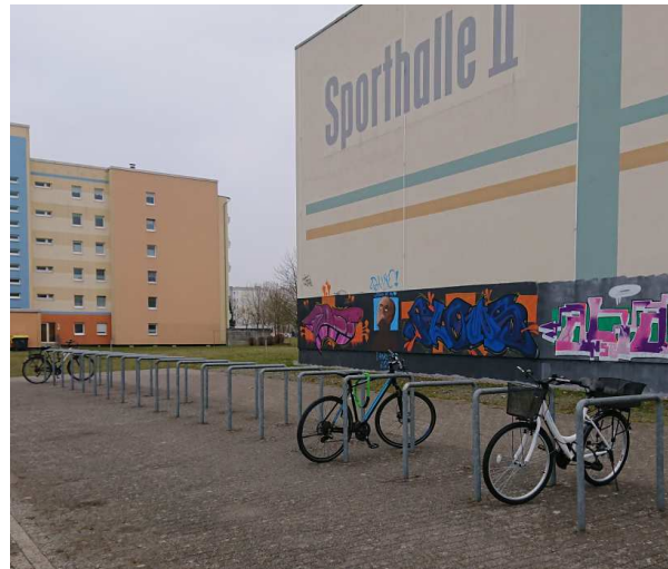
Vorhandene schlichte Fahrradabwehrbügel, verzinkt, wiederverwenden
