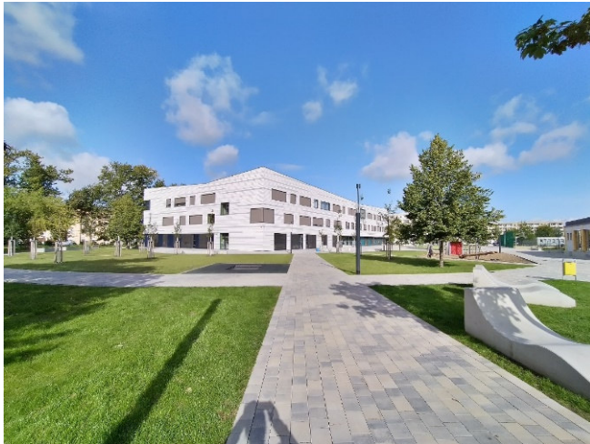
Abbildung 3: das Schulgelände der IGS Erwin Fischer wurde 2020 komplett fertiggestellt
