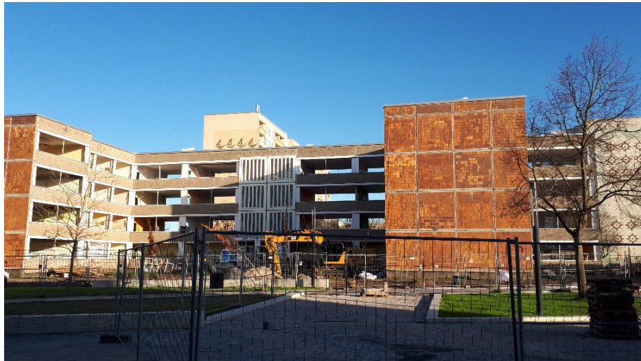
Abbildung 1: Abbruch Bestandsgebäude der Integrierten Gesamtschule „Erwin Fischer“
