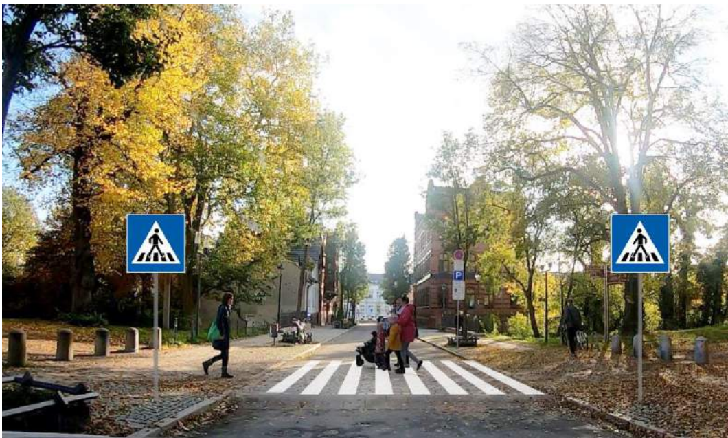
Abbildung 55: Martin-Luther-Straße als Bestandsbeispiel für den empfohlenen Mindeststandard (oben) und als Visualisierung für die Empfehlung inklusive Fußgängerüberweg (unten)
