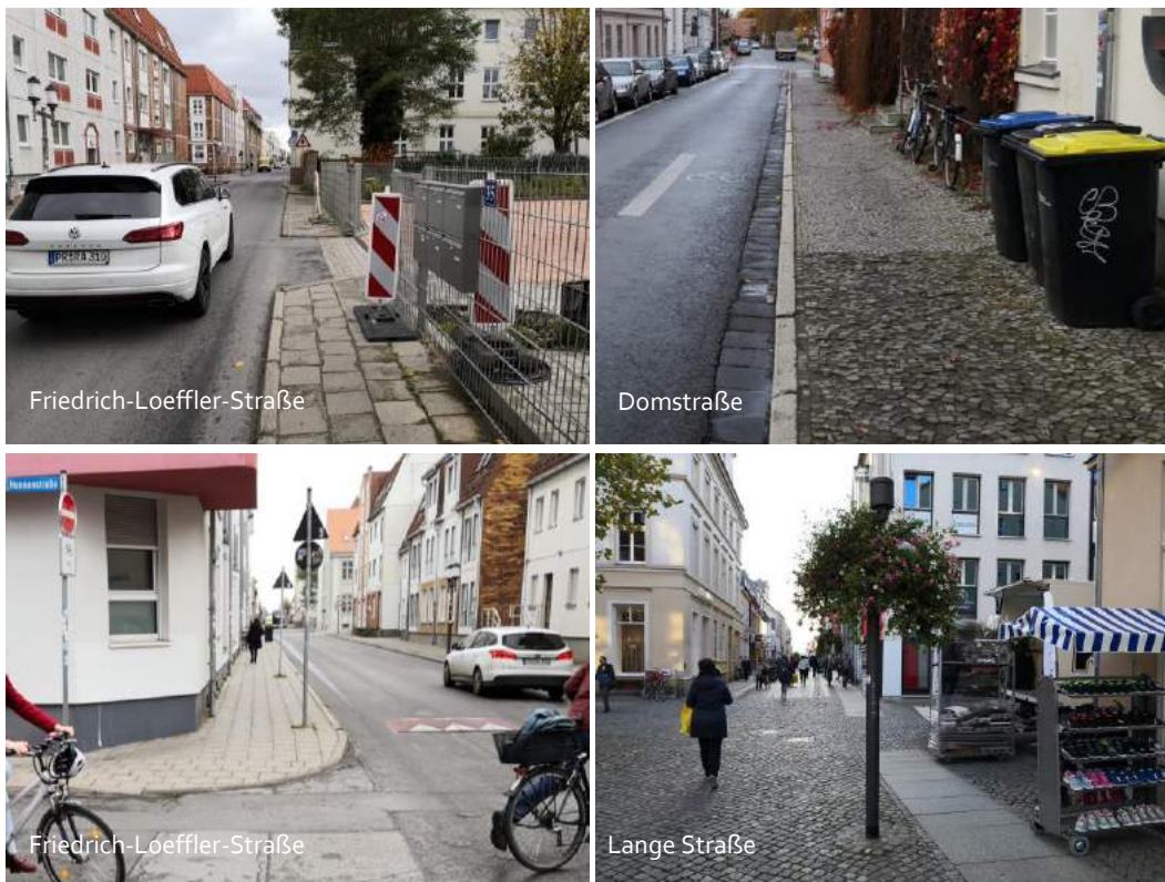
Abbildung 13: Mängel in Gehwegbreite und Oberfläche
