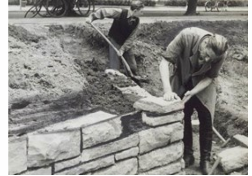
Aufbau einer Trockenmauer
