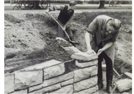
Aufbau einer Trockenmauer
