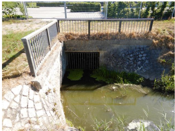
Abbildung 3-5: Kastendurchlass am Bahnhof
