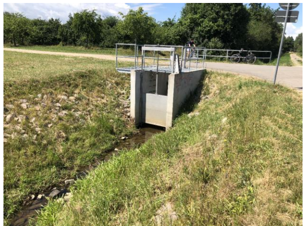
Abbildung 3-7: Wehrtafel am Regensammler-Süd zur Drosselung des Hochwasserabflusses im Graben 25
