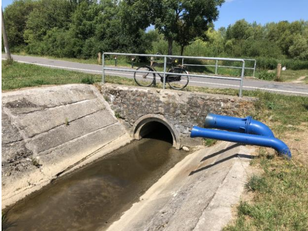
Abbildung 3-2: Auslauf Schöpfwerk Scharnhorststraße
