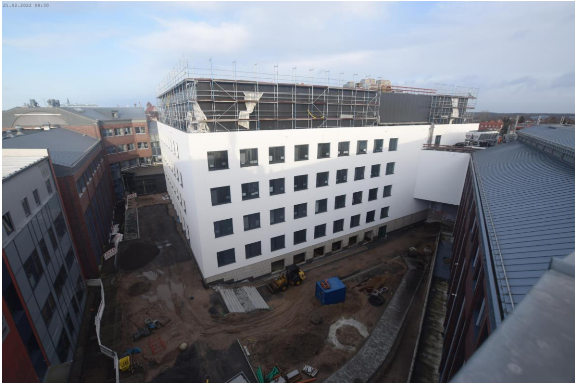
Abbildung 3: Arbeiten am Dachgeschoss - Zentrum für Life Science und Plasmatechnologie
