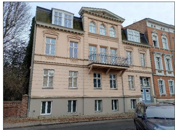
Abbildung 22: Altes Stadtarchiv Arndtstraße 2 [Foto: Immobilienverwaltungsamt]
