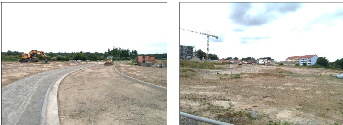
Abbildung 20: Erschließungsarbeiten im Bebauungsplan Nr. 13 – Am Eisenpark [Foto: Immobilienverwaltungsamt]
