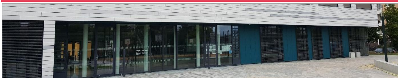
Abbildung 11: Integrierte Gesamtschule "Erwin Fischer"
