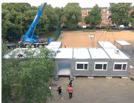
Abbildung 6: Containeranlage auf dem Hof der Karl-Krull-Schule
