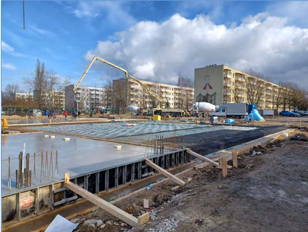
Abbildung 2: Fundamentarbeiten Sporthalle III
