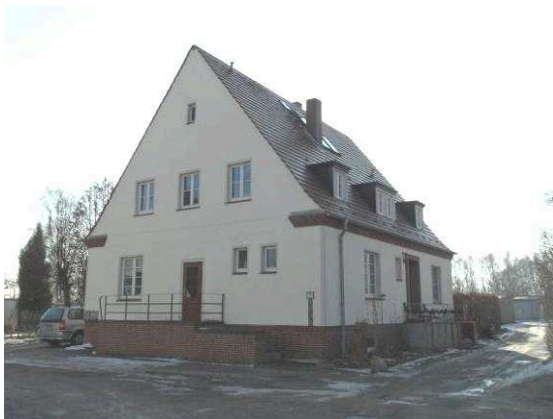
Abb. 16: Ehem. Sanitätsoffiziershaus Clara-Zetkin-Str. 14
