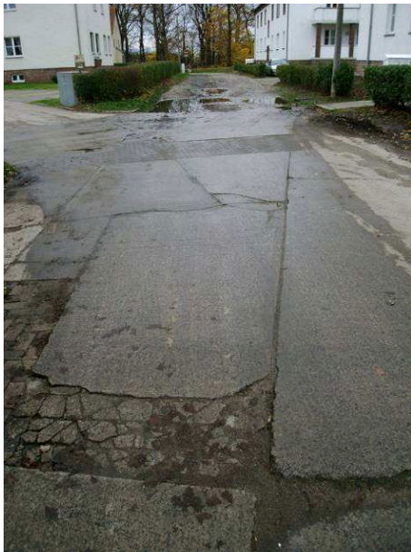
Abb. 46: Betonschäden
