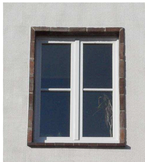
Abb. 65: Fenster mit Klinkersohlbank und – Türgevände/ Faschen
