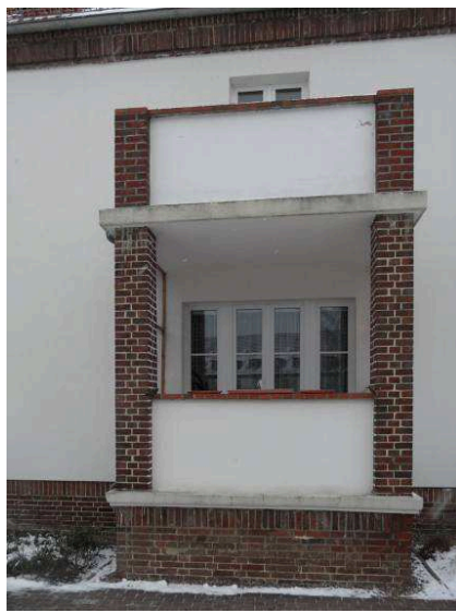
Abb. 73: massive Balkonkonstruktion, M.-Reimann-Str. 21-25
