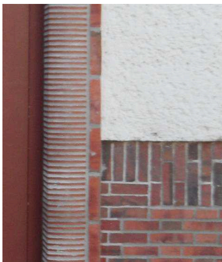
Abb. 64: Klinkerdetail mit Grob-/Kratzputz
