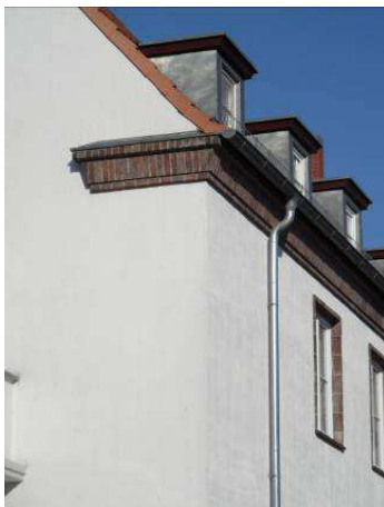
Abb. 67: vorh. mögliche Aus- führung Ortgang und Gaube
