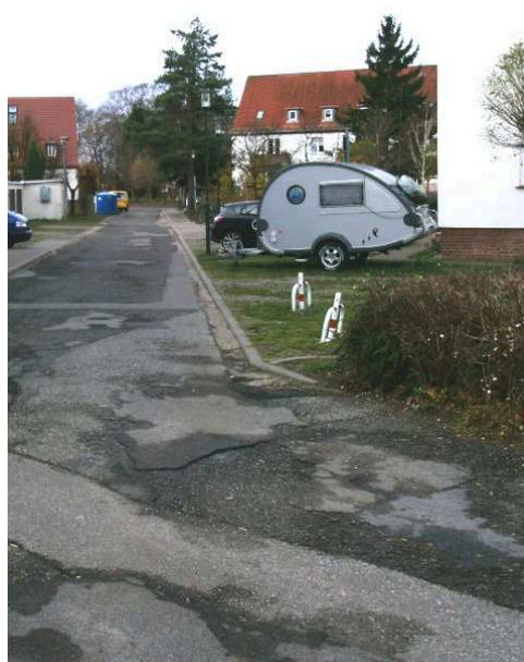
Abb. 47: Asphaltschäden
