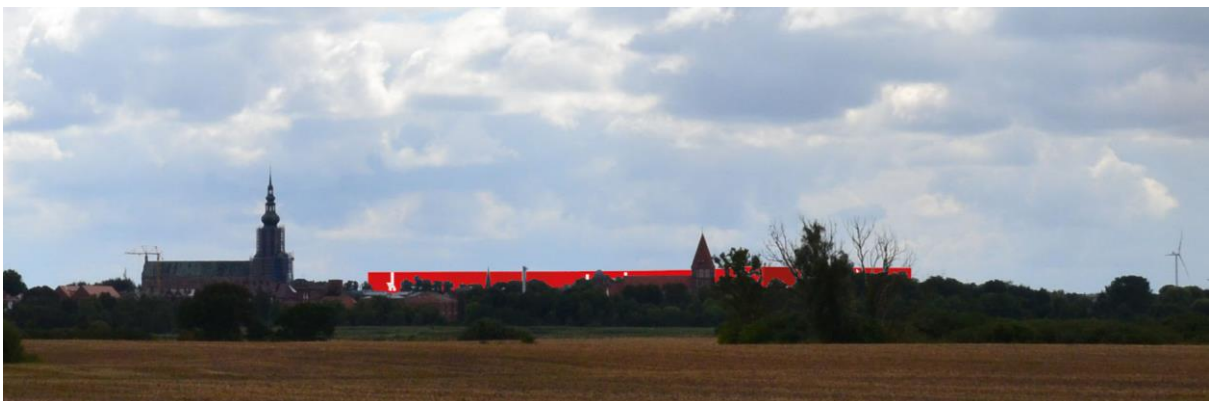
Abbildung 13: Standort 1, Detailansicht WEA West
