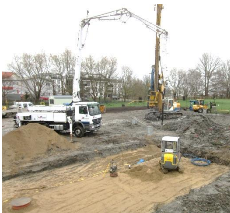
Abbildung 1: Gründungs- und Erschließungsarbeiten für das neue Stadtarchiv
