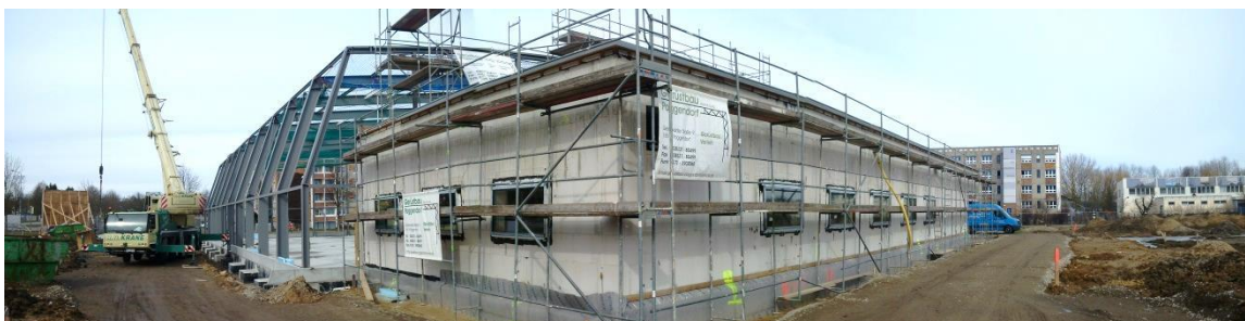
Abbildung 5: Rohbau der neuen Zweifeldsporthalle an der Caspar-David-Friedrich-Schule
