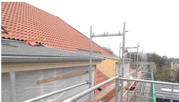
Abbildung 3: Sanierungsarbeiten am Dachgeschoss der Arndt-Schule
