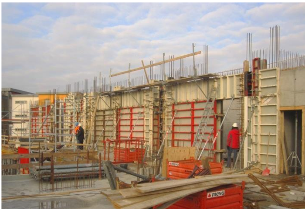
Abbildung 4: Rohbau der neuen IGS Erwin Fischer
