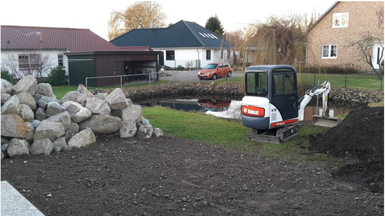
Anhang 1: Blick Richtung Südwesten von der Crednerstraße in das Planungsgebiet (Dachsel, 2.12.2016)
