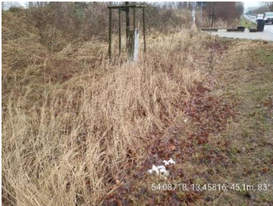
Abbildung 3: Straßengraben an der L 26
