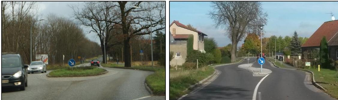
Abb. 6 Beispiele Ortseingangsgestaltung mit Fahrstreifenversatz
