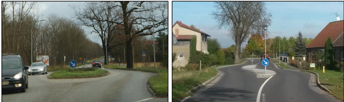
Abb. 6 Beispiele Ortseingangsgestaltung mit Fahrstreifenversatz
