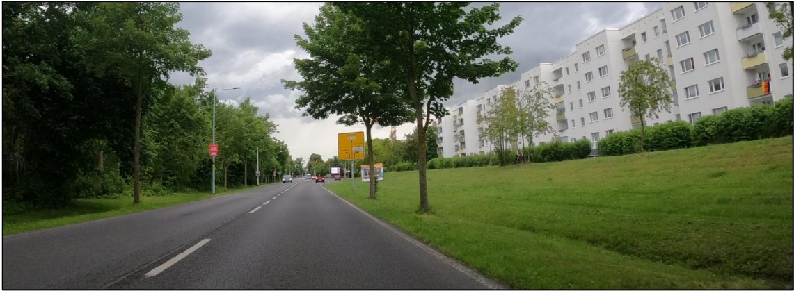
Abb. 18 Bestandssituation Anklamer Landstraße
