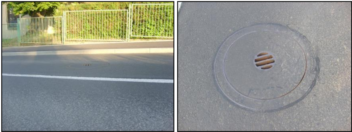
Abb. 7 Lärmarme Schachteindeckung (Beispiel Dresden)
