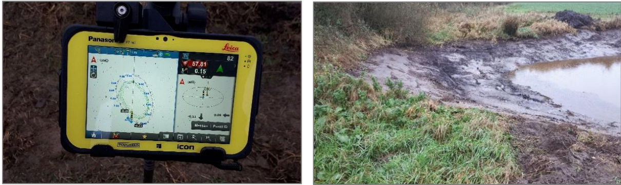
Abbildung 23: Einmessen der Böschungskante mit moderner GPS Technik, Abstecken mit Holzpflocken und Böschungsgestaltung mit dem Bagger
