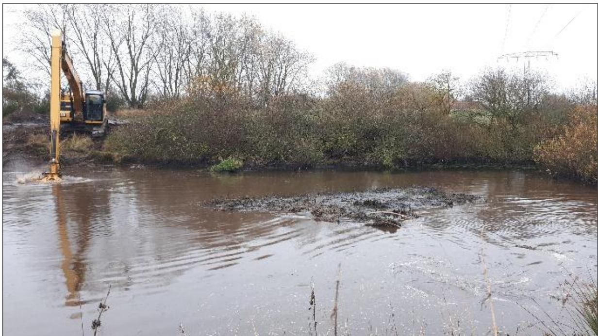
Abbildung 24: Arbeiten mit dem Langarmbagger im November 2024, im Vordergrund: eine Kranichbrutinsel wird geschaffen
