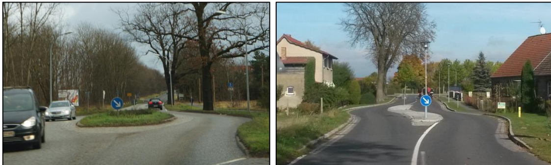
Abb. 13 Beispiele Ortseingangsgestaltung mit Fahrstreifenversatz
