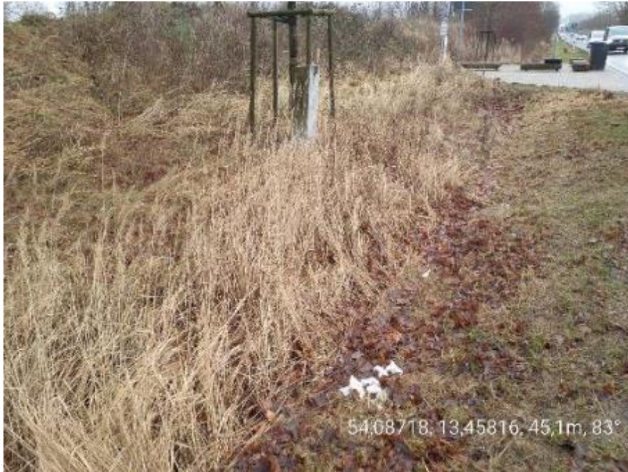
Abbildung 3: Straßengraben an der L 26
