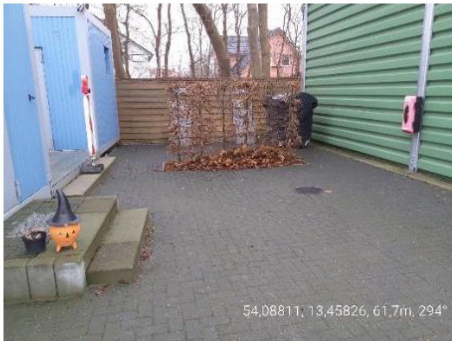
Abbildung 9: Pflasterung zwischen Sanitärcontainer und Lagerhalle
