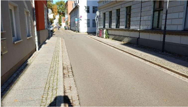
Umbaubeispiel Bader- und Domstraße (Lutherstraße)
