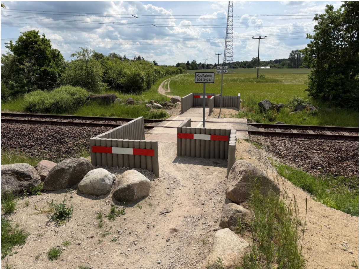
Bild 2: Guest Gleisübergang (offiziell)
