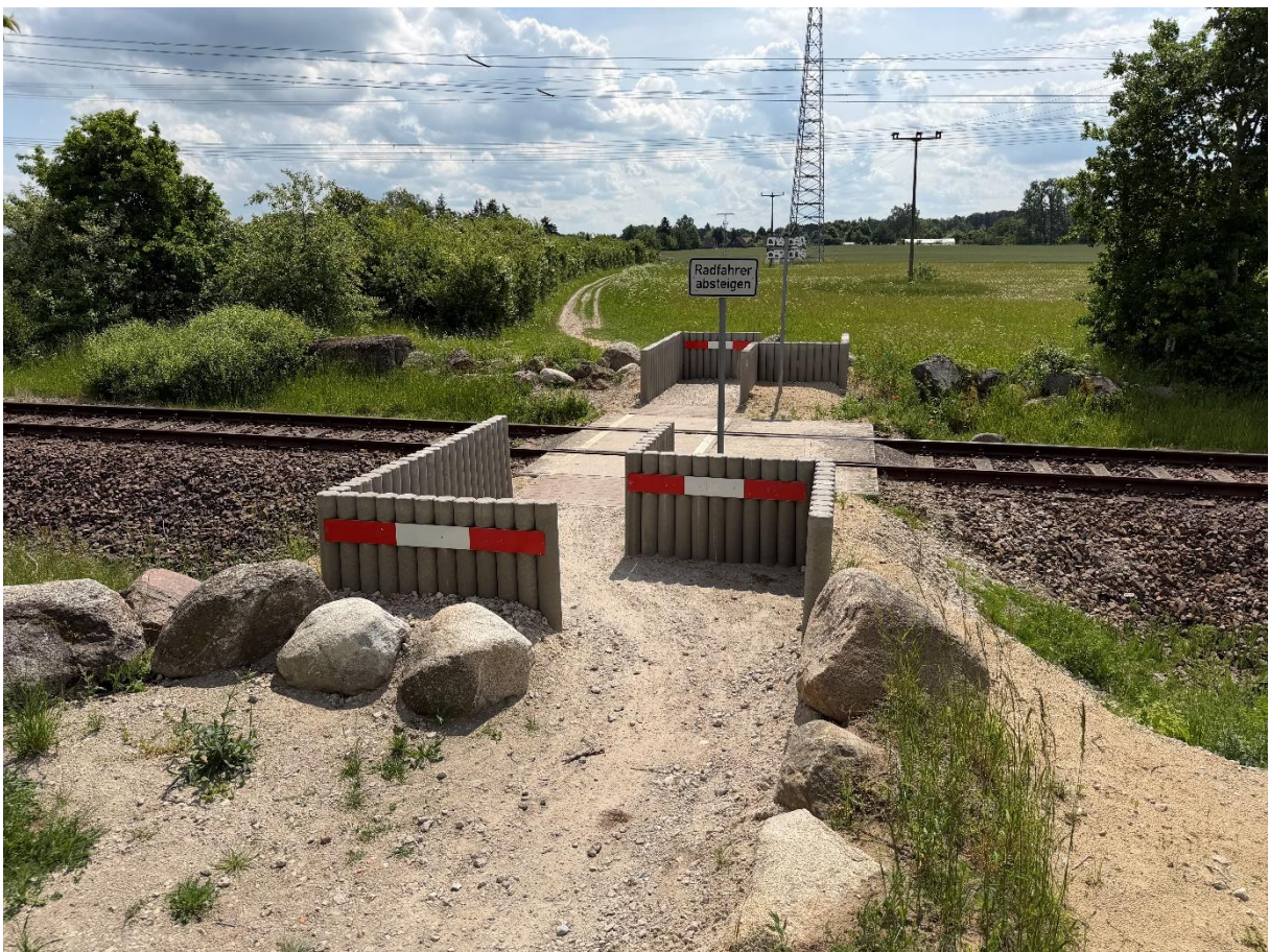
Bild 2: Guest Gleisübergang (offiziell)
